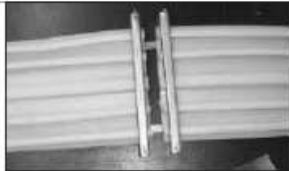
I. Włożyć końcówki taśm w uchwyty. I. Insert waterstop ends.
