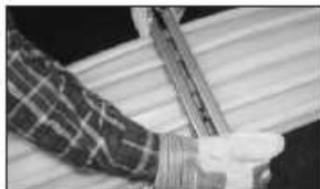
IV. Ścisnąć ze sobą nadtopione końce taśmy na ok. 2 min. IV. Push molten ends of waterstop together.
