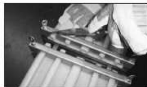
II. Używając ostrego noża równo przyciąć końcówki. Następnie umieścić taśmy w uchwyty pozostawiając końcówki o długości ok. 10mm. II. Using a sharp knife, cut both ends to be welded straight and square. Then locate waterstop in jig, with approx. 10 mm protruding.
