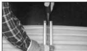
III. Włożyć zgrzewarkę i przycisnąć metalowe uchwyty do siebie. Pozostawić w tej pozycji aż plastik się stopi, pozostawiając szew ok. 5 mm. Usunąć zgrzewarkę. III. Insert hot blade and push waterstop ends against blade. Maintain contact until plastic molds into bead of about 5 mm diameter. Remove knife.
